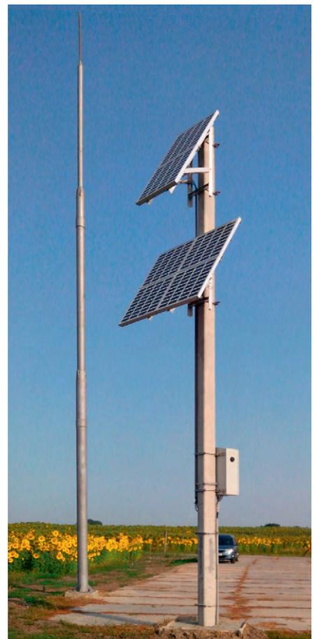
Рис. 5. Внешний вид оборудования автоматизации скважины
