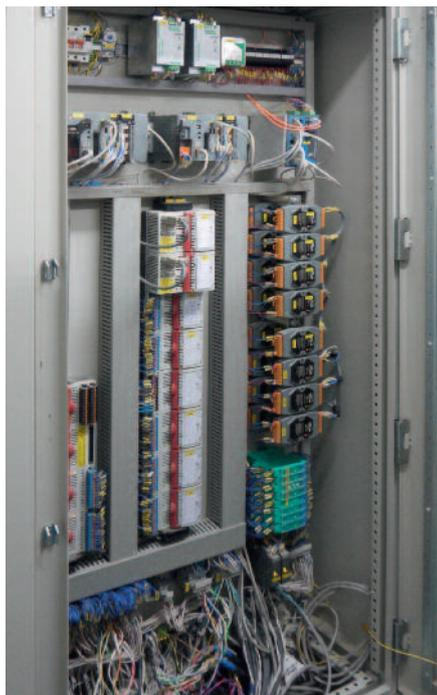
Рис. 4. Шкаф контроллеров PCY
