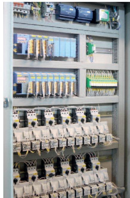
Рис. 6. Шкаф управления электроприводом запорной арматуры
