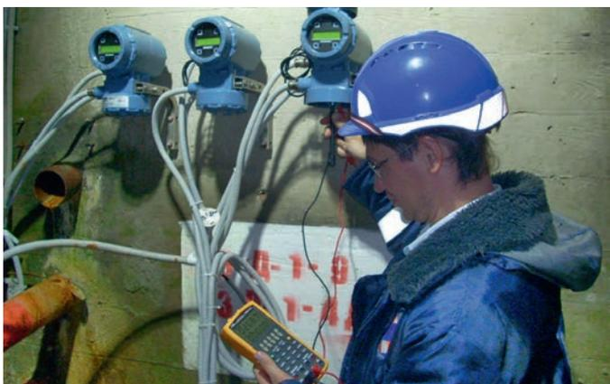
Рис. 5. Настройка контрольно-измерительной аппаратуры
