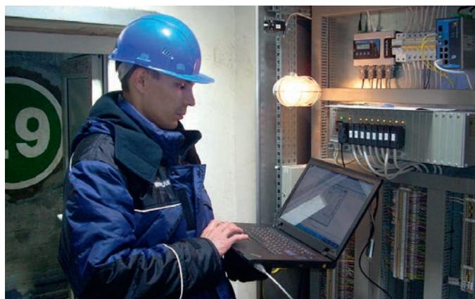
Рис. 6. Тестирование измерительных каналов
