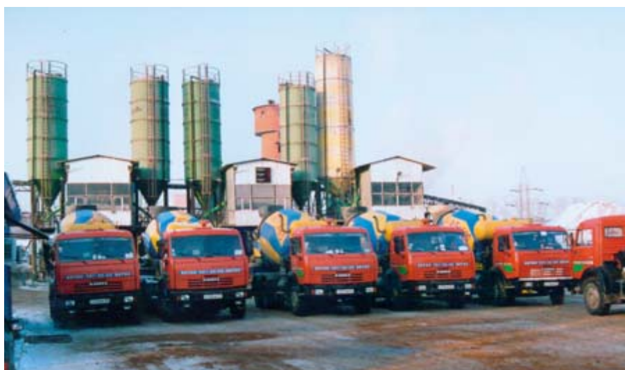
Бетонный завод ООО «Торговый Дом Одинцово»
