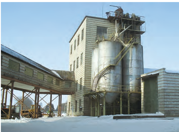
Рис. 1. Здание размольного участка ГП «Козловский спиртовой завод»
