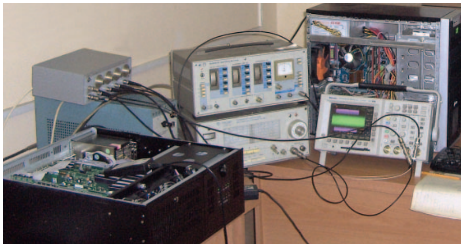
Рис. 5. Оборудование рабочего места в процессе проведения испытаний системы
