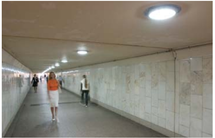
Рис. 2. Светильники ДВУ-25, выполненные на основе светодиодов Cree, установлены в одном из подземных переходов столицы
