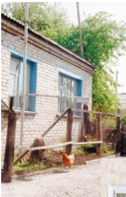
Рис. 4. Пример размещения автоматического пункта контроля в жилом доме. Виден блок детектирования, закрепленный на мачте антенны
