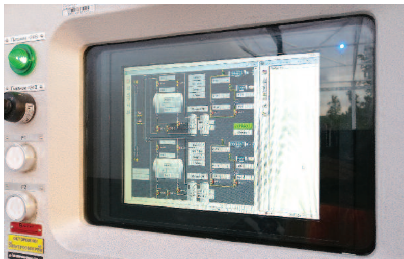
Рис. 3. Пост управления бункеровкой – резервный пост управления КБГС
