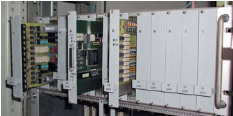
Рис. 6. Блок управления 10 огнями светофоров (БУСОФ)
