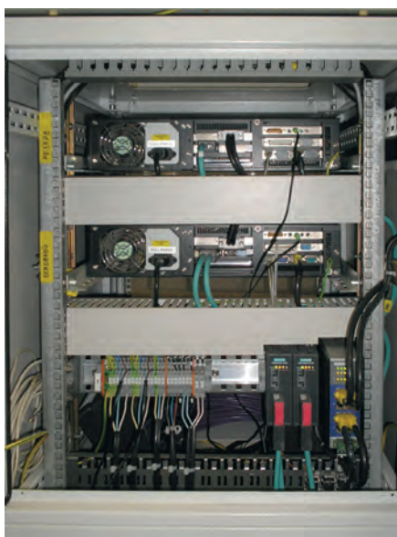
Рис. 3. Стойка системных блоков АРМ ДСП (вид сзади)
