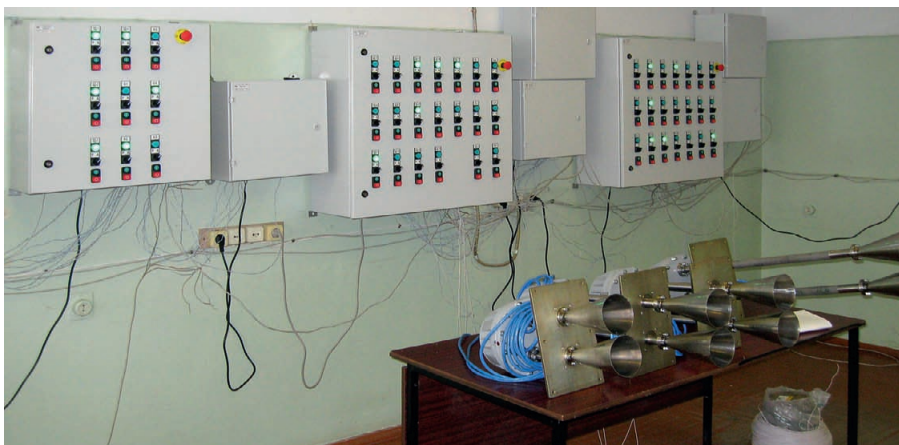
Рис. 3. Шкафы управления на этапе проведения испытаний
