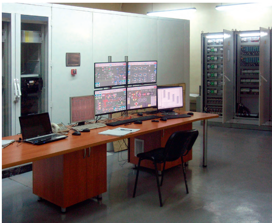
Рис. 1. Групповой щит управления (ГрЩУ) – рабочее место машиниста турбоагрегата
