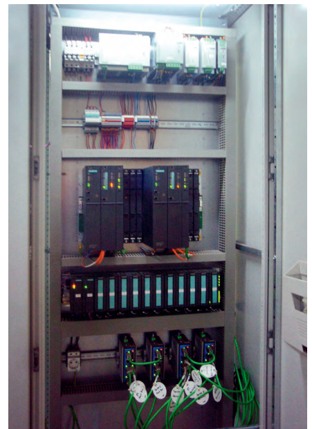
Рис. 9. Шкаф управления с резервированным контроллером S7-416-5H
