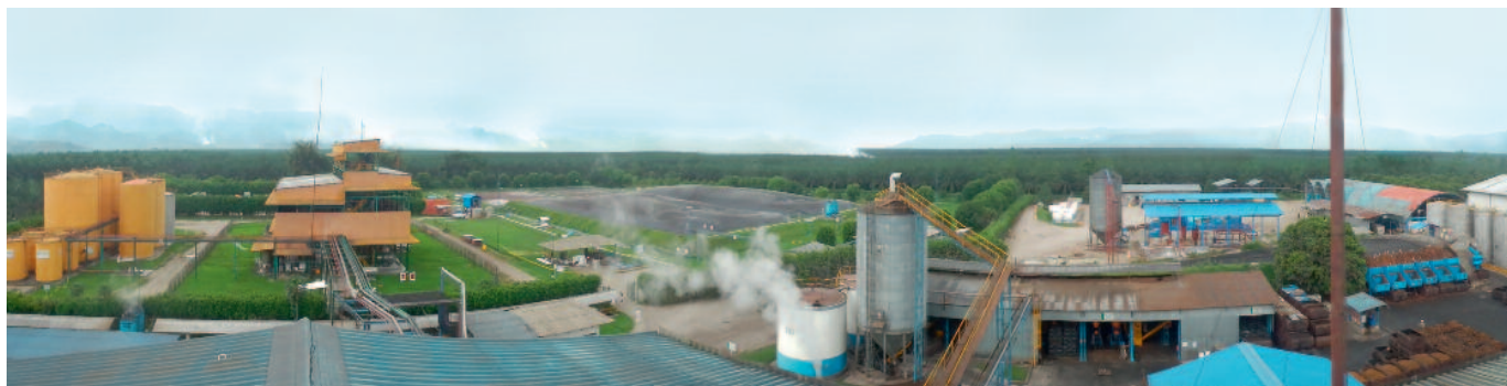
Рис. 4. Биогазовая станция в Перу ↑→
