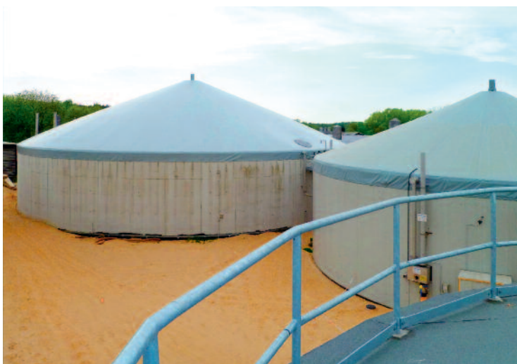
Рис. 1. Вид типовой биогазовой станции
