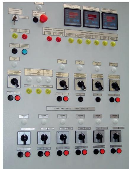
Рис. 10. Шкаф ШУ1-МГ: органы управления и сигнализации
