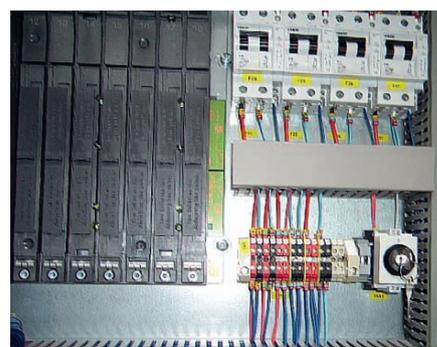
Рис. 7. Шкаф AD-D: установка автоматов защиты
