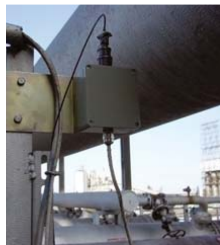
Рис. 5. Канал преобразователя АЭ
