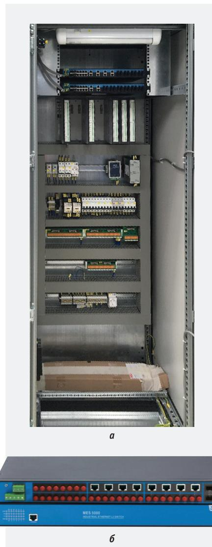
Рис. 4. Коммутатор Zonedata MES5000 для применения на объектах энергетики: внешний вид (а); установка на объекте (б)
