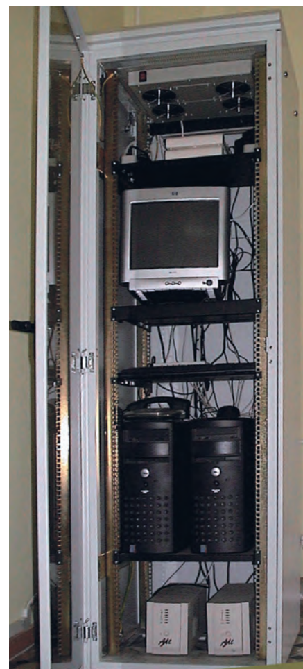
Рис. 6. Серверная стойка центрального диспетчерского пункта
