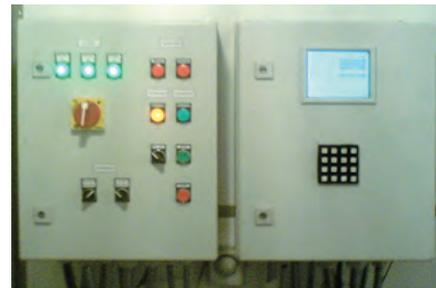
Рис. 6. Комплект управляющего оборудования для подогревателя нефти
