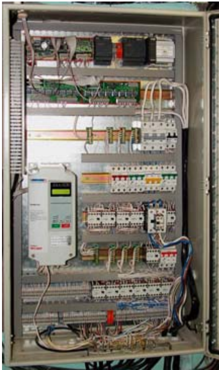
Рис. 6. Шкаф системы управления
