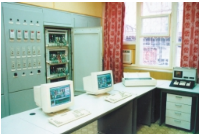
Рис. 2. Помещение операторов АСУ ТП
