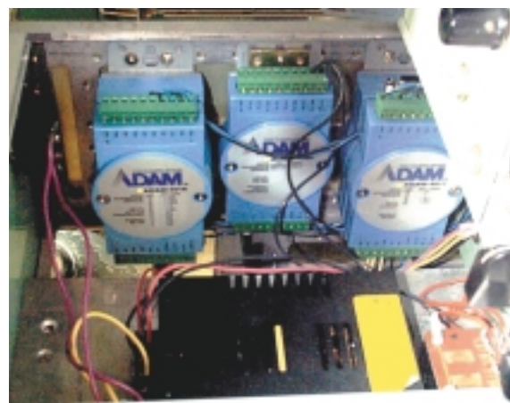
Рис. 3. Расположение модулей ADAM в стойке управления установки
