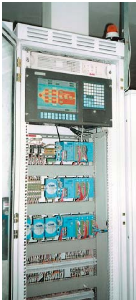
Рис. 5. Шкаф с рабочей станцией AWS-843 варочной части печи
