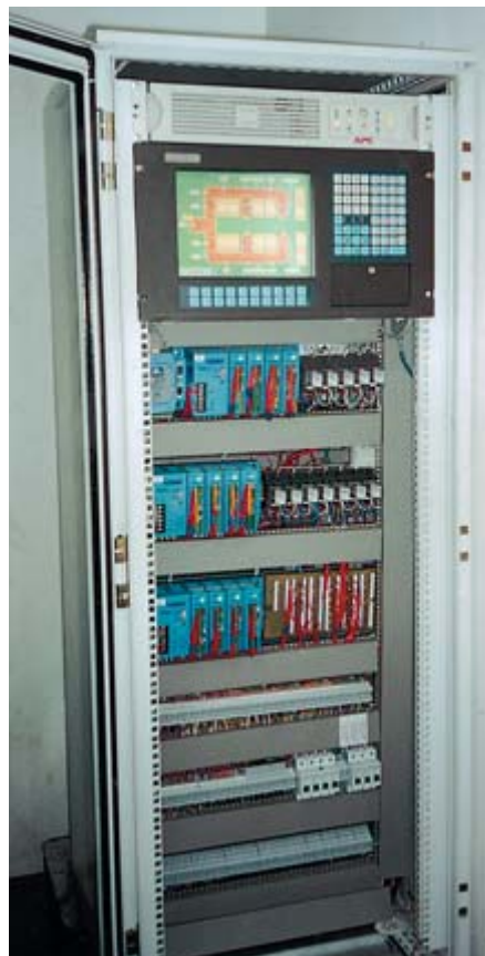
Рис. 4. Шкаф с рабочей станцией AWS-843 фидерной части печи
