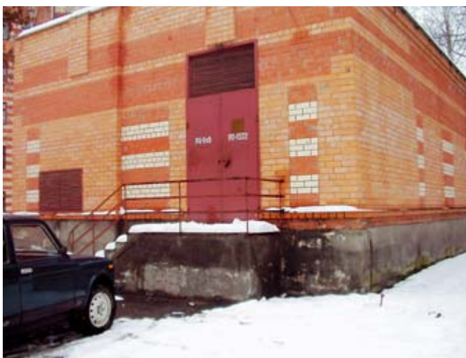
Здание распределительного пункта электросети
