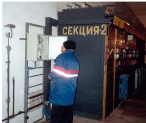
Рис. 9. Разработанные на базе устройств MicroPC контроллеры успешно эксплуатируются в условиях неотапливаемых помещений РП
