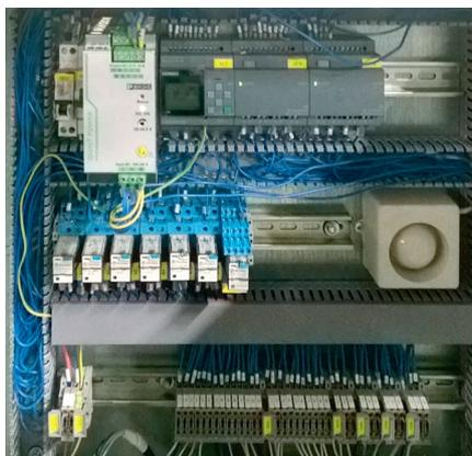
Рис. 3. Электрооборудование системы, установленное на монтажной панели пульта
