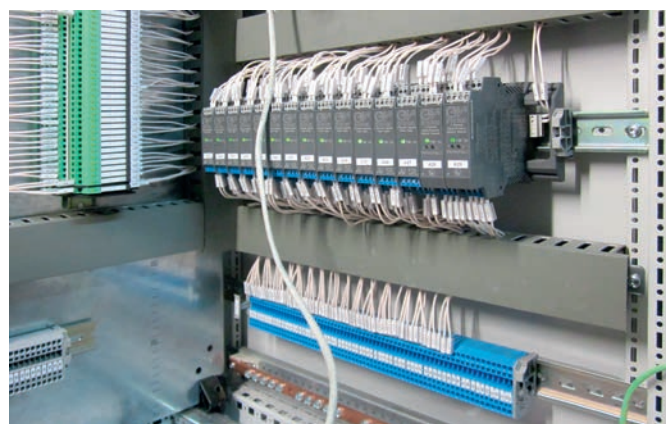
Рис. 5. Барьеры искробезопасности GM International в составе шкафа системы управления
