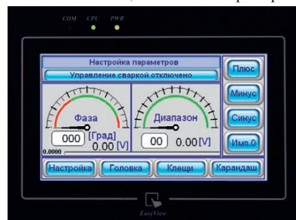
Рис. 3. Панель управления установкой контактной сварки
