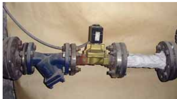
Рис. 3. Электромагнитный клапан подачи пара в камеру
