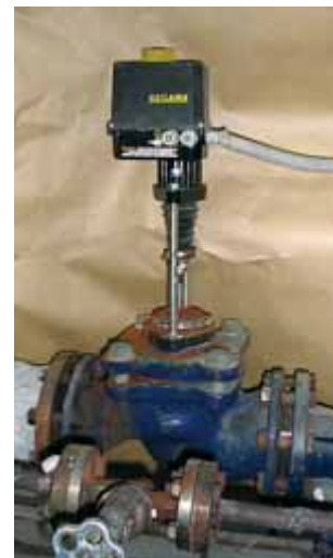
Рис. 2. Запорно-регулирующий клапан подачи пара
