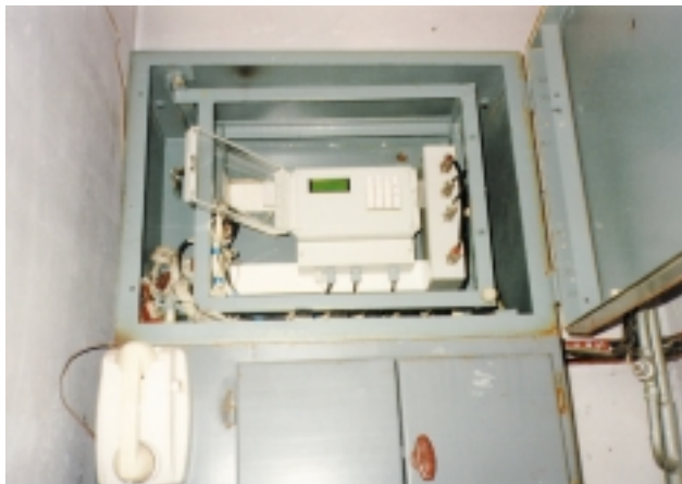
Рис. 3. Внешний вид регистратора РПС-СГ1 с открытой защитной дверцей
