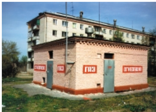
Типичный газораспределительный пункт, где устанавливается регистратор
