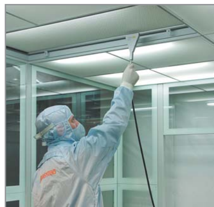
Рис. 4. Аттестация чистой зоны после монтажа
