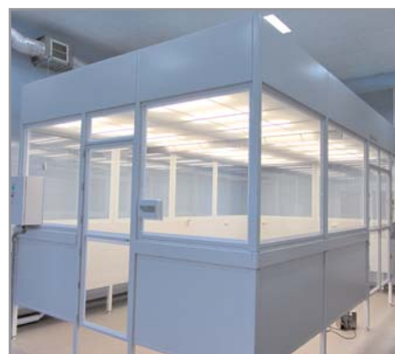
Рис. 3. Размеры рабочей зоны комплекса 5000 × 3000 × 2400 мм
