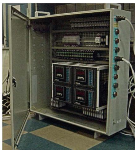
Рис. 2. Шкаф вторичных преобразователей и весовых терминалов
