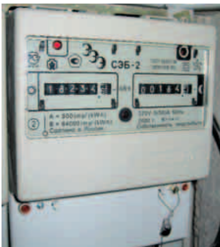
Рис. 1. Электросчетчик с импульсным выходом
