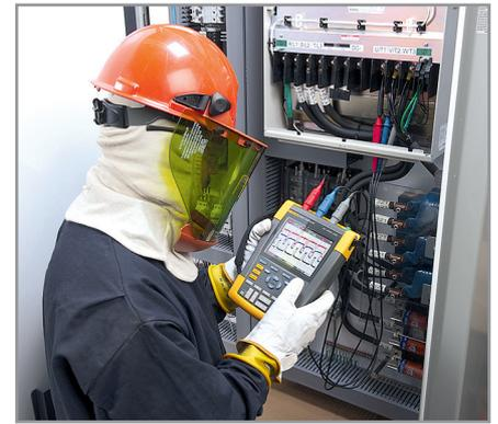
**Рис. 3. Работа с осциллографом в высоковольтных цепях**
