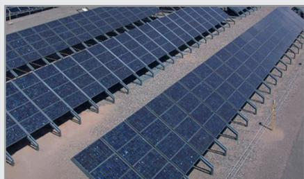
Наиболее популярный тип современных солнечных батарей использует фотоэлектрические ячейки. Их работа основана на восприятии фотонов света определённой энергии и сообщения возбуждения электронам, после чего те устремляются в движение по проводнику, генерируя ток. Такая схема не идеальна и оставляет множество места для последующего улучшения.
