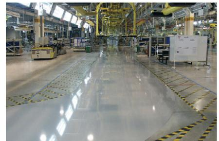
Рис. 2. Покрытие ROMPOX® 1107 ESD на предприятии автомобильной промышленности в Китае
