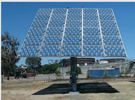
Кроме повышения эффективности преобразования в самих фотовольтаических элементах, улучшить эффективность генераторов можно путём увеличения количества попадающего на них света, что достигается с помощью применения оптических концентрирующих систем (concentrator photovoltaic, CPV). Однако в этом случае резко увеличиваются требования к системе отвода тепла от преобразующих элементов, поскольку его избыток как минимум снижа-
