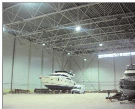
**Энергосберегающее освещение индукционными лампами эллинга в С-Петербурге (порт Дубровка)**
